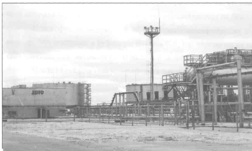
Рисунок 2.1 - Дожимная насосная станция - 8 Лянторского месторождения
